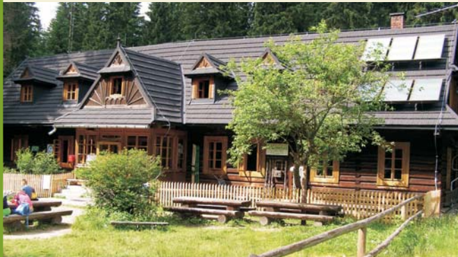
Tatrzańskie schronisko PTTK w Dolinie Roztoki. Baterie słoneczne na dachu dostarczają ekologicznej energii.
